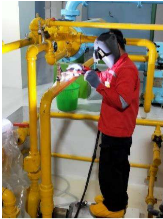
GAMBAR 1. Proses Pengelasan Housing pada Pipa Pendingin Primer
