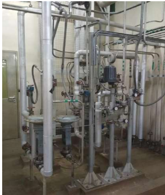
GAMBAR 3. Sistem Pemanasan dan Pendinginan pada Tangki Pelarutan DI-301
